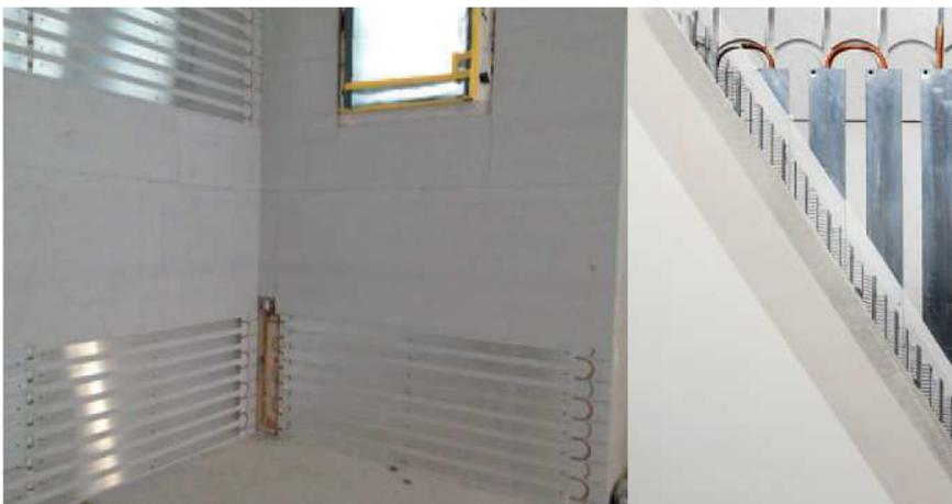
Abb. 1: Feuchteregulierende Klimaplatteninnendämmung in einer Ebene mit Wand Heiz- und Kühlsystem.
