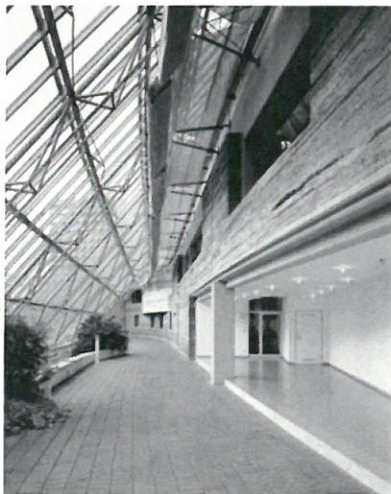
Abbildung 19: Lehmwand mit Glasfassade
