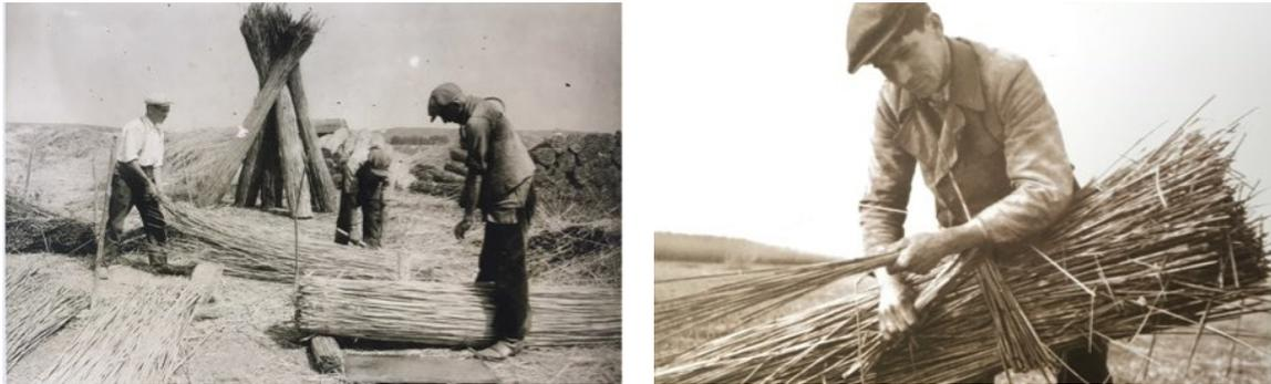
Abb. 5. u. 6. Schilfschnitt mittels Stoßeisen
