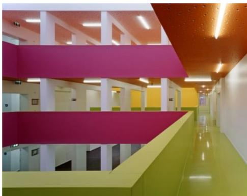
Abbildung 7 Schallabsorbierende Decken in leuchtenden Farben (Quelle:
