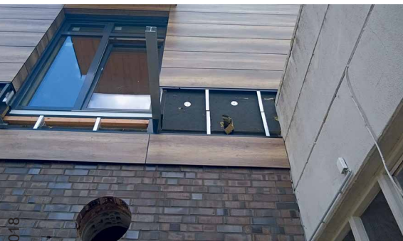
Abb. 7: Montage der Vorhangfassade mit kaschierten Mineralwolle-Dämmplatten (© Trauco-Spezialbau GmbH)
