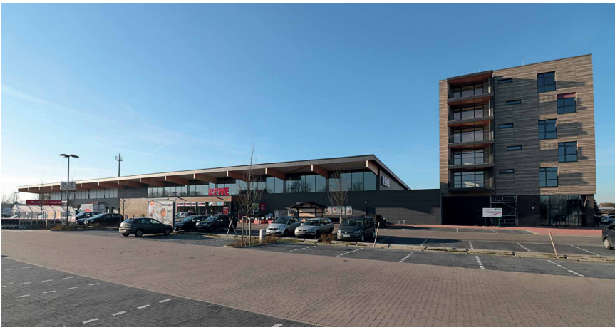
Abb. 19: Fertiges Ensemble aus Wohnturm und Supermarkt (© Mennerich GmbH / Lutz Bosian)
