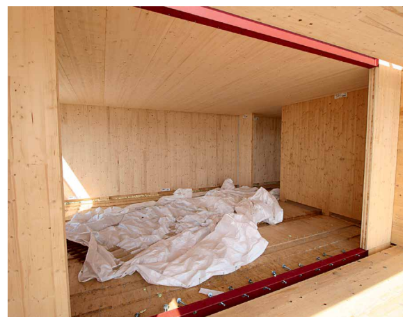
Abb. 11: Der Rohbau aus massiven BSP-Elementen (© Mennerich GmbH/Lutz Bosian)
