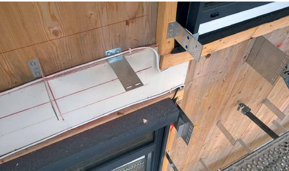
Abb. 6: Montagewinkel auf der BSP-Außenwand (© Trauco-Spezialbau GmbH)
