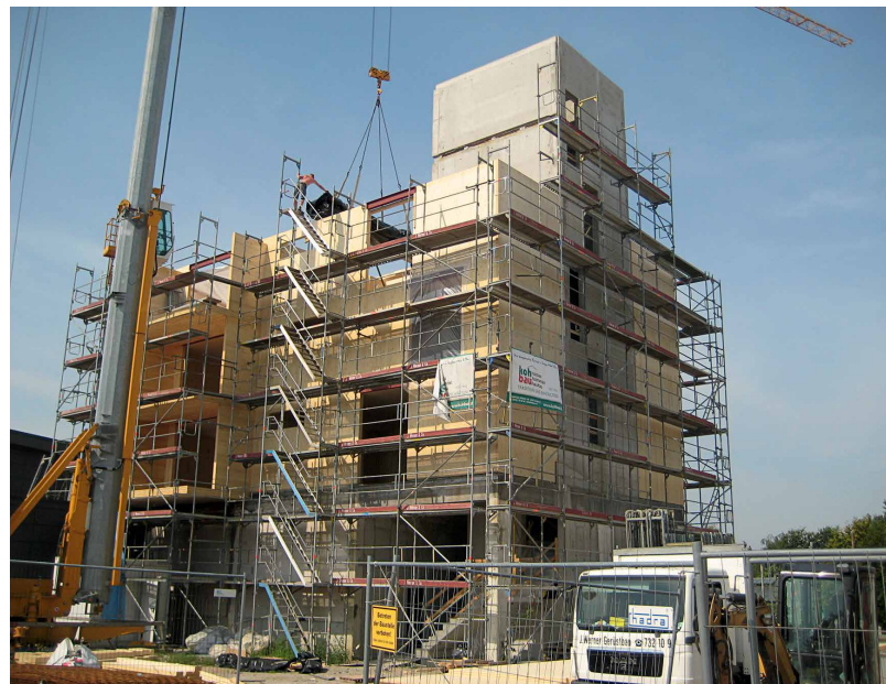
Abb. 5: Der mineralische Erschließungskern mit Treppenhaus und Aufzug steift die Konstruktion aus. (© Mennerich GmbH/ Lutz Bosian)
