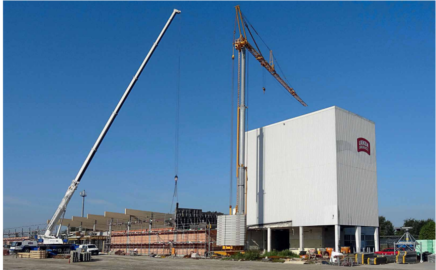
Abb. 4: Baubeginn am Getreidesilo und Errichtung des benachbarten Supermarkts (© Mennerich GmbH/ Lutz Bosian)
