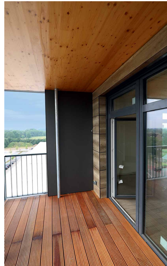
Abb. 18: Die angehängten Balkone aus BSP-Elementen hat man an der Unterseite in Sichtqualität ausgeführt (© Mennerich GmbH/ Lutz Bosian)
